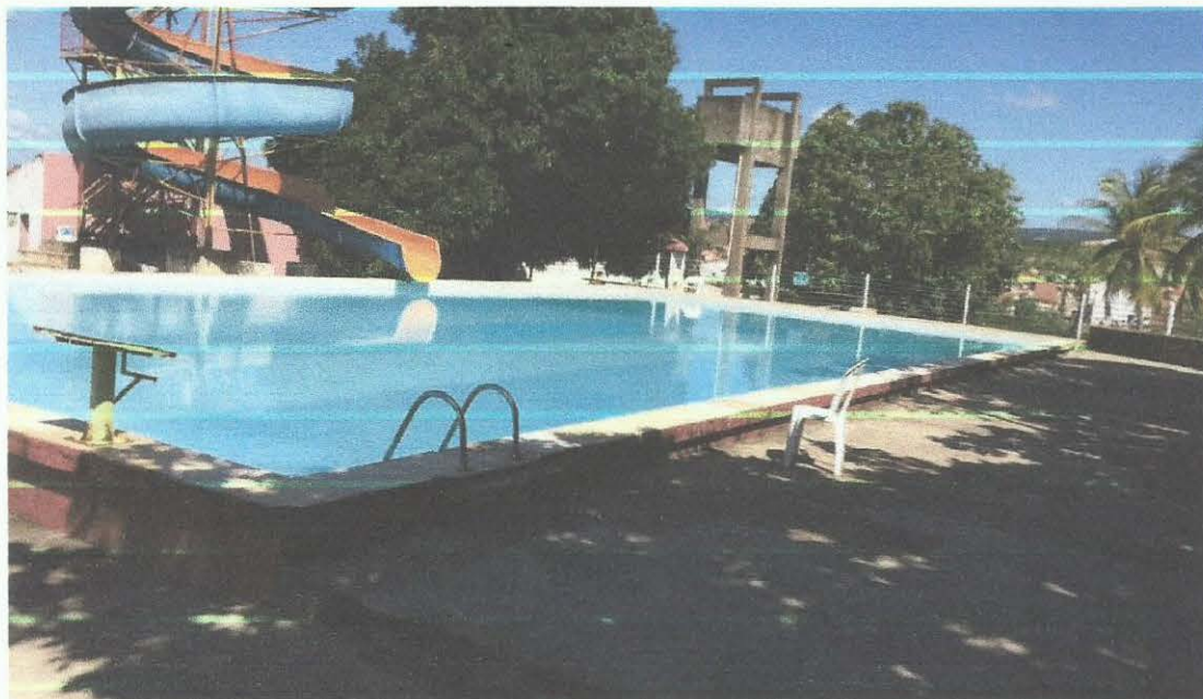
Figura 02: Lateral da piscina
