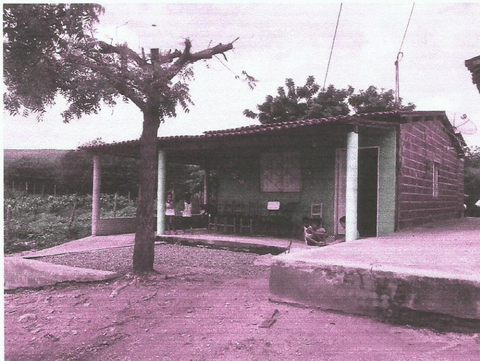
Vista frente x lado esquerdo do imóvel avaliando
