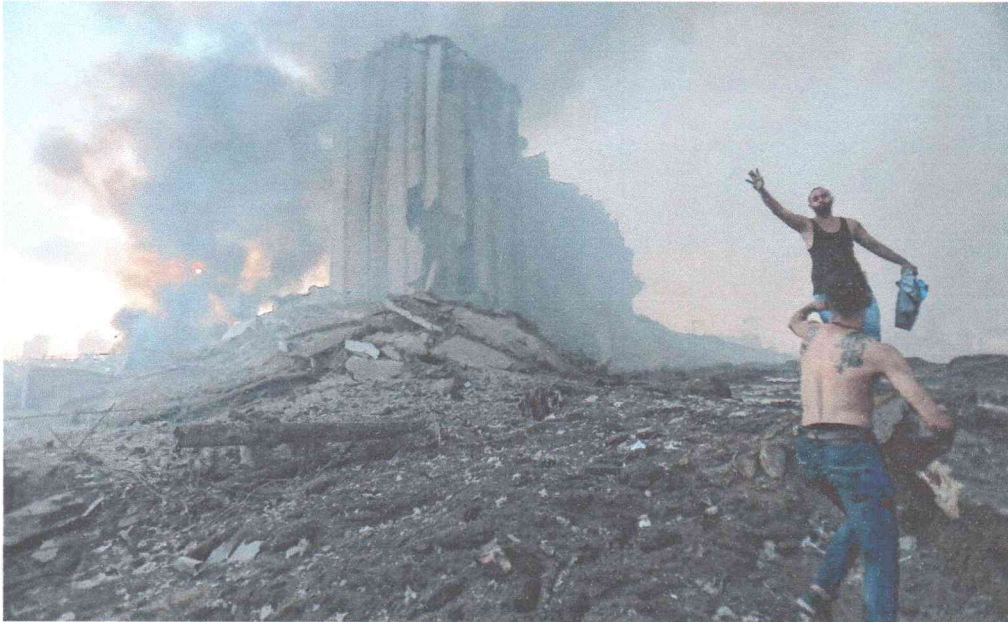
EXPLOÇÃO sacudiu edifícios e causou destruição em um raio de até 13 quilômetros da zona portuária de Beirute
