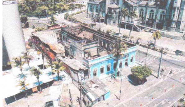
IMÓVEL ao lado da Catedral Metropolitana corre risco de desabamento após incêndio na noite de sábado. 5
