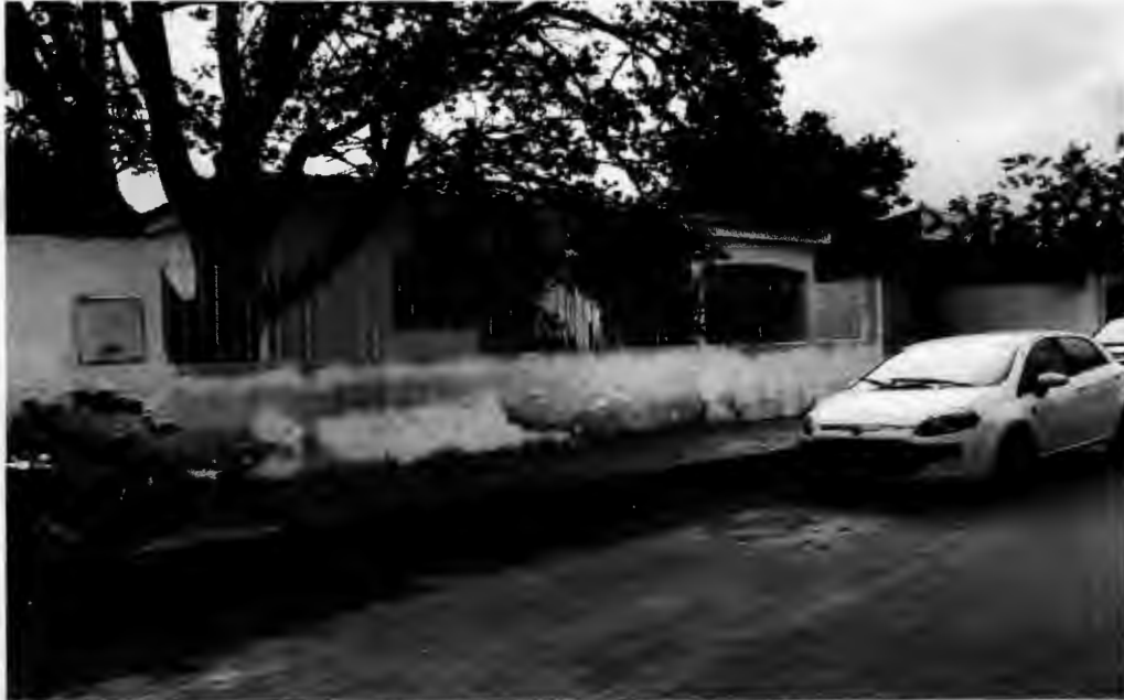
Vista frente x lado direito do imóvel avaliando
