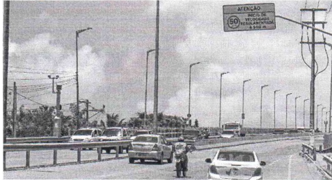
PLACAS SINALIZAM velocidade máxima permitida diferente em diversos pontos das vias
