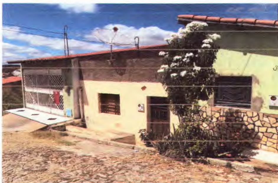
Vista frente x lado esquerdo do imóvel avaliando
