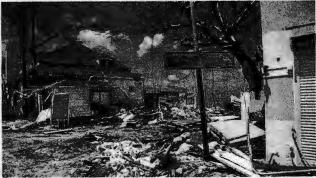
Edifícios colapsados em Grand-Case, na ilha caribenha francesa de Saint-Martin; cenário de destruição
