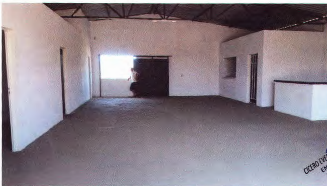
Vista interna - Imóvel avaliando
