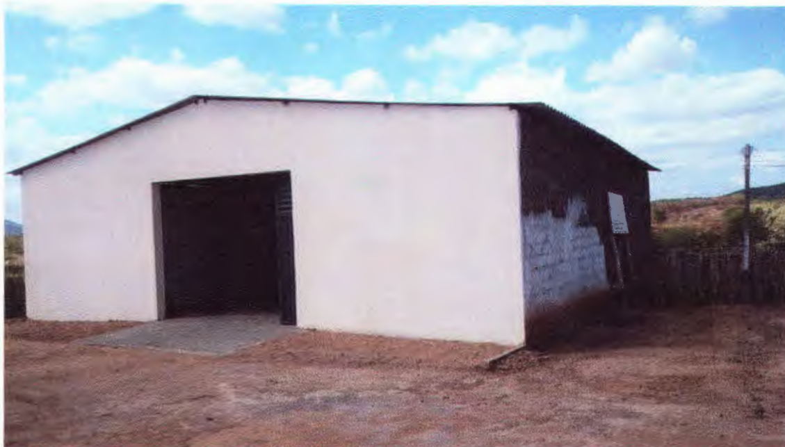
Vista fundo x lateral esquerda - Imóvel avaliando
