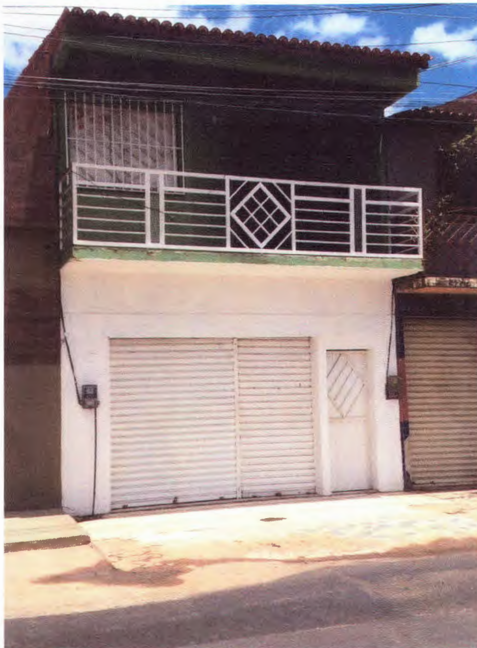
Vista fachada do imóvel avaliando
